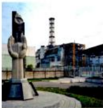
La centrale nucléaire de Tchernobyl en août 2008. En arrière plan, on aperçoit le réacteur n° 4 où se produisit l'explosion le 26 avril 1986.
